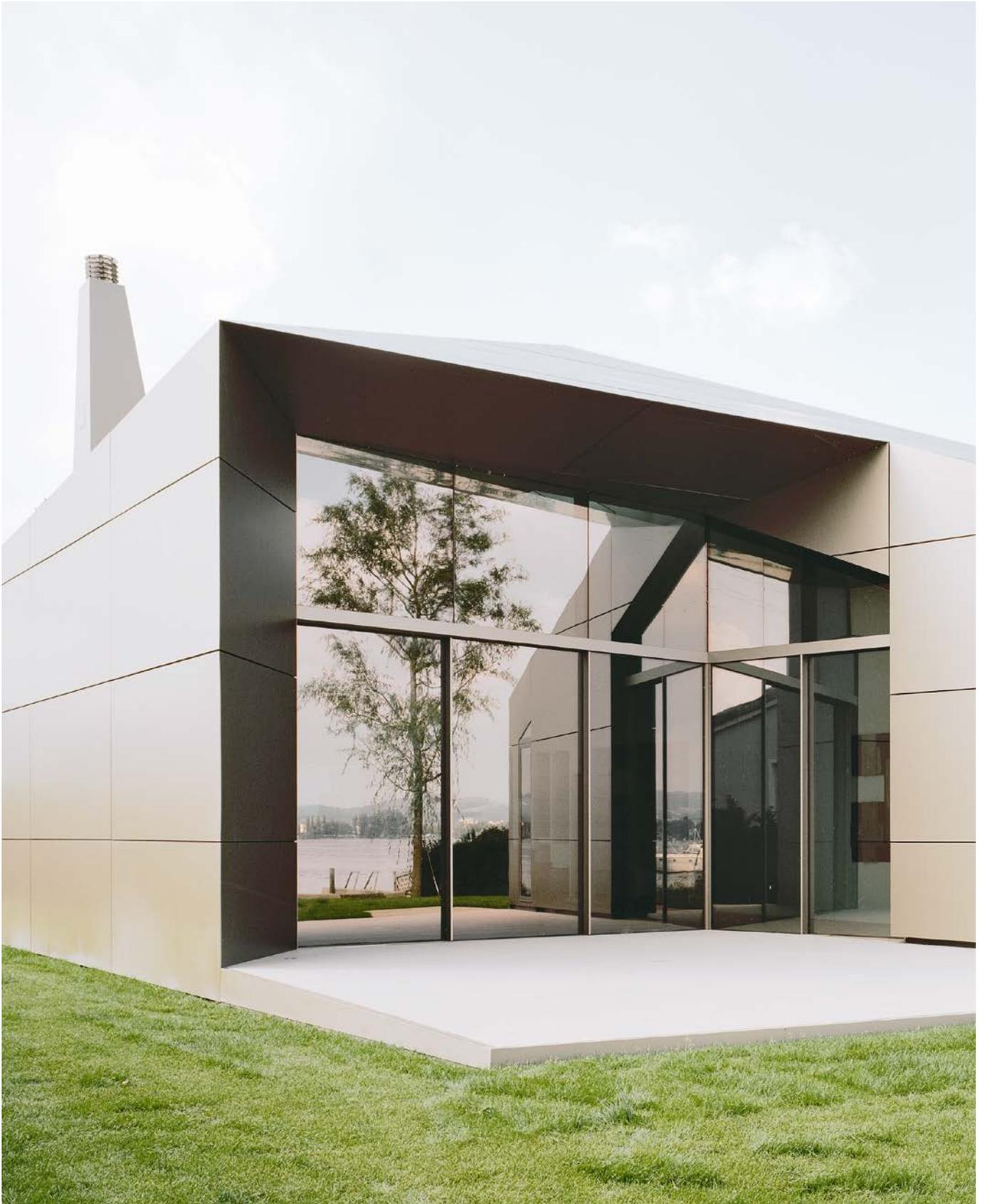
Toutes les versions du système offrent une excellente protection contre les effractions grâce au collage des verres isolants avec les profils GFK et à son dispositif de verrouillage multipoints. Selon les besoins en matière de sécurité, la fenêtre coulissante peut être équipée de composants supplémentaires.
